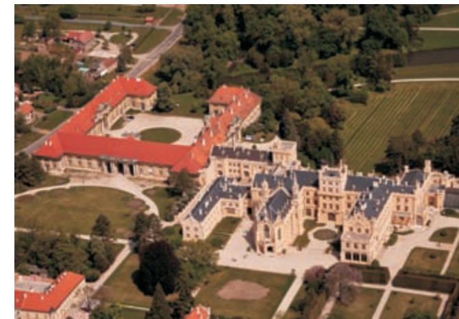
Zámek Lednice a areál jízdáren (Foto Vojtěch Zapletal)
